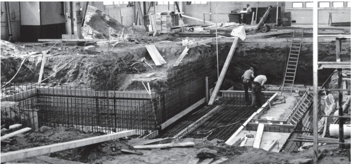
*Les fondations dans le BM 11 sont importantes pour un socle de 340 m<sup>3</sup> de béton armé reposant sur 22 pieux de 50 tonnes de portance.*
