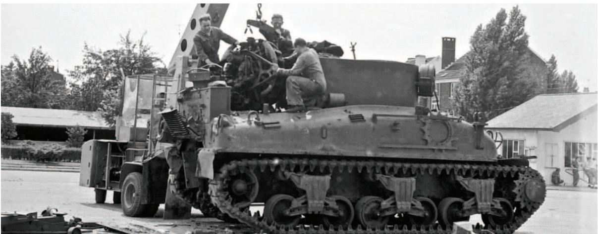
*Une dépanneuse enlève le moteur d'un char dépanneur Sherman à proximité du corps de garde.*
